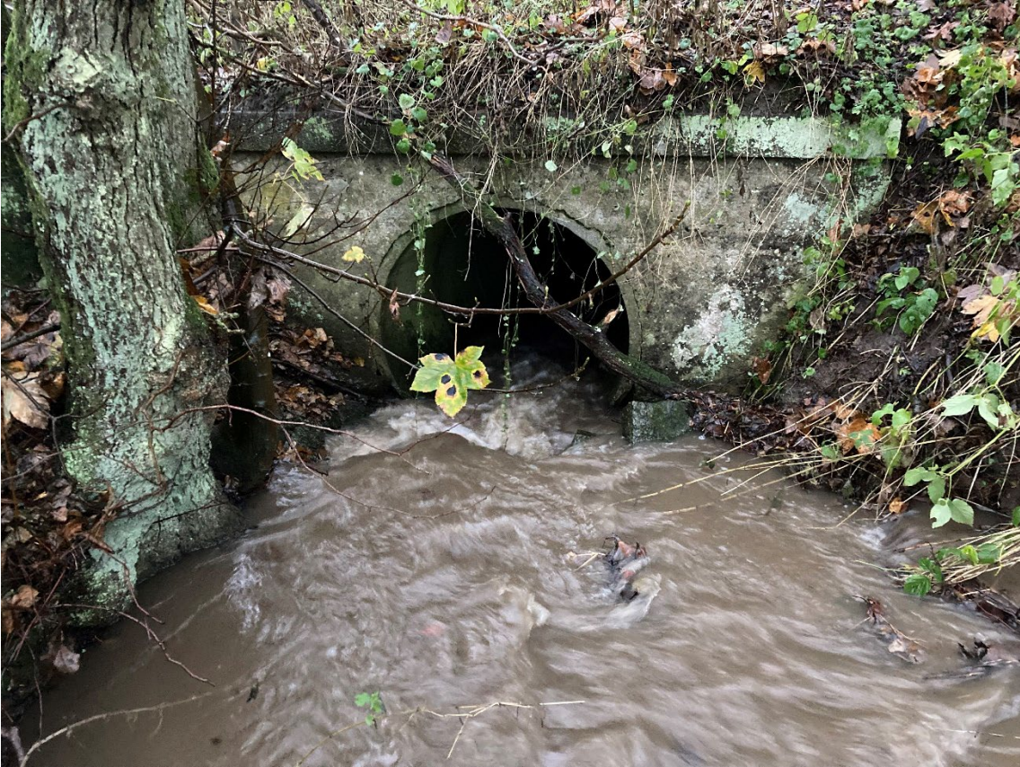
Figur 4. Indløb i rørledningen, december 2021
